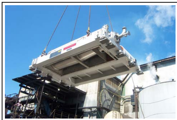
Instalación de Decantadora
